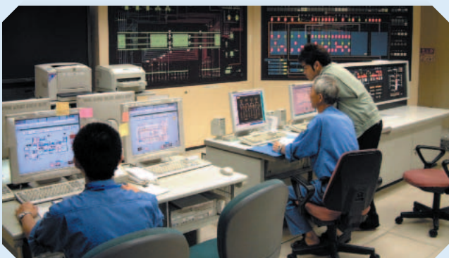
東大病院のエネルギーを陰で支える人々：写真は、エネルギーセンター中央監視室。エネルギーセンターでは、病院のライフラインを常に維持管理している
