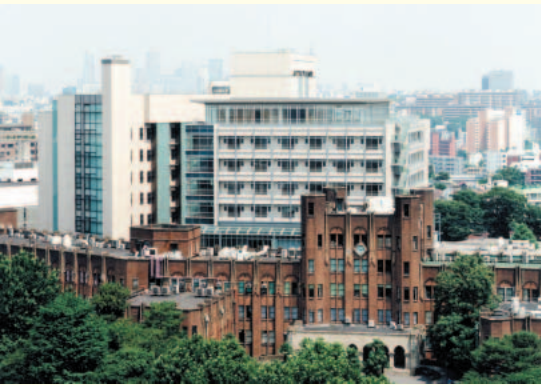
1号館（手前）および総合研究棟（左奥）と 新病院棟（右奥）
